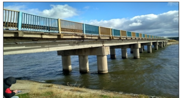
Рис. 3. Фото мостової споруди під реконструкцію
